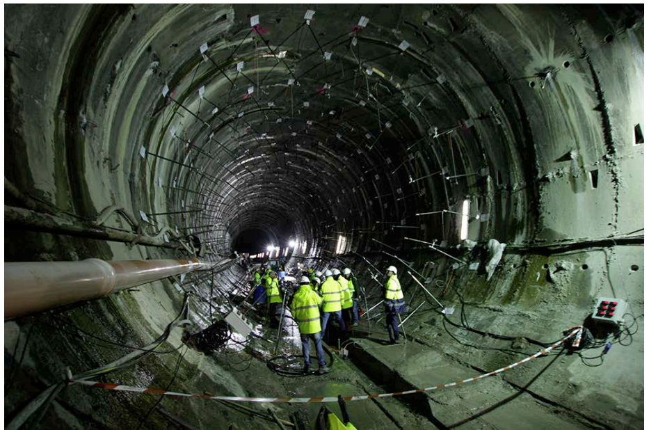
Equipo de obra del túnel de Pajares.
