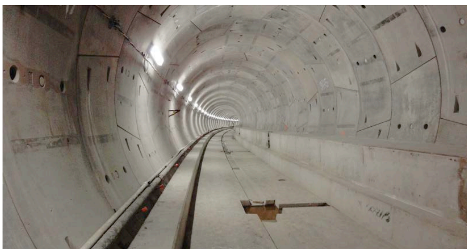
Vista general de uno de los túneles TBM acabados.
